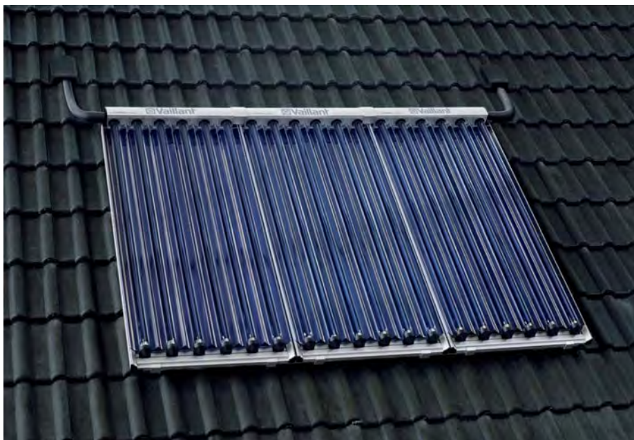
Montáž tří kolektorů auroTHERM exclusiv VTK 570 na střechu
