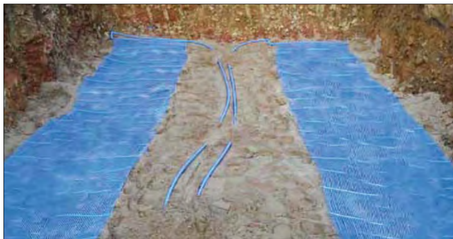
Položení kompaktního kolektoru
