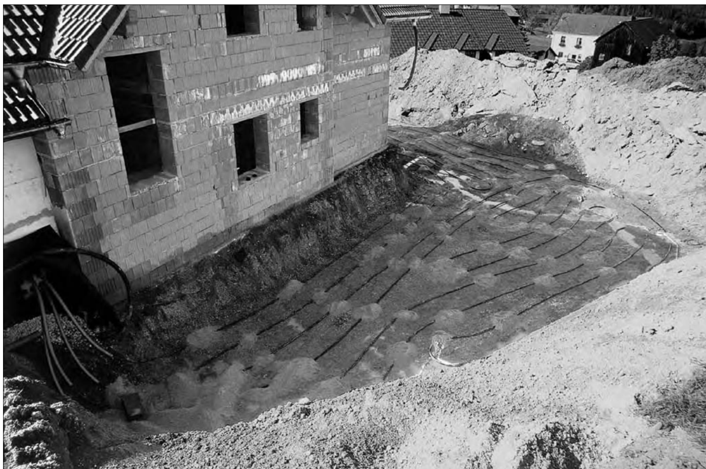
Zemní kolektor před zasypáním pískem
