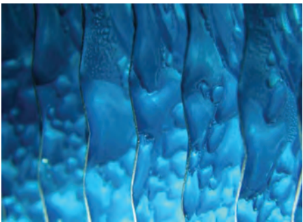
Hliníkové lamely výmenníka vonkajšej jednotky
